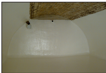
Intérieur rénové du château d'eau
