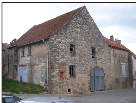
Vue de l'ancien bâtiment.
