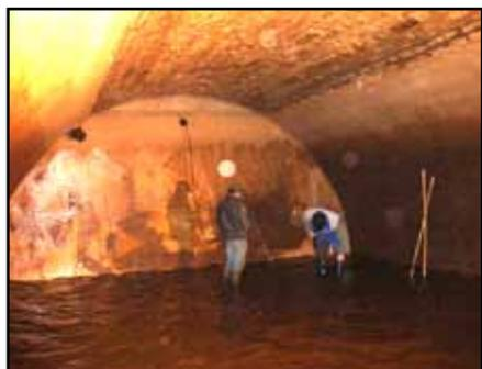
Nettoyage du réservoir d'eau.
