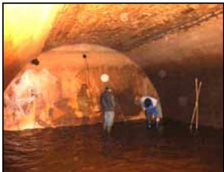
Nettoyage du réservoir d'eau.
